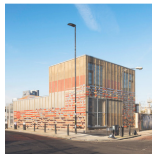
Modulinės struktūros perdarytos iš statybinių atliekų (Hub 67, Londonas)
